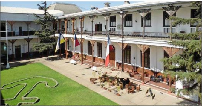
El patio ancla, en el ala norte del edificio, que está completamente habilitado.
