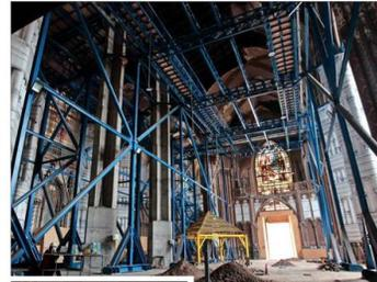
El interior de la iglesia exhibe la estructura metálica que permitió una estabilización provisoria. En la imagen de abajo, daños posteriores.
